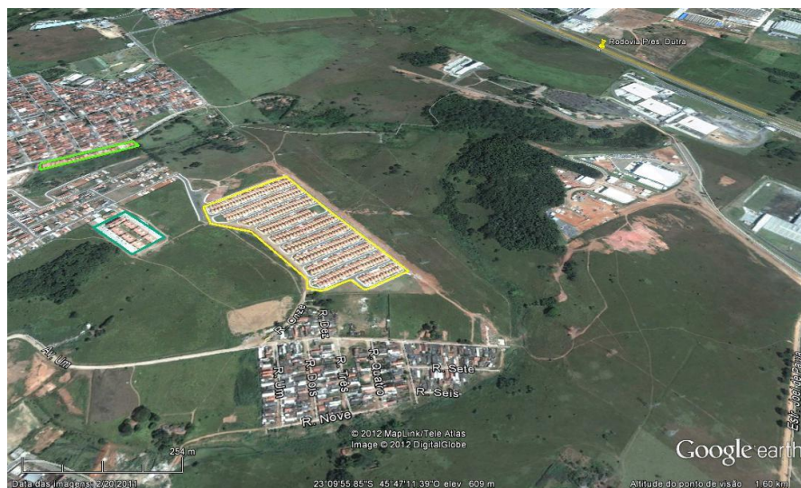
Figura 10: Residencial Frei Galvão. Região Leste.
