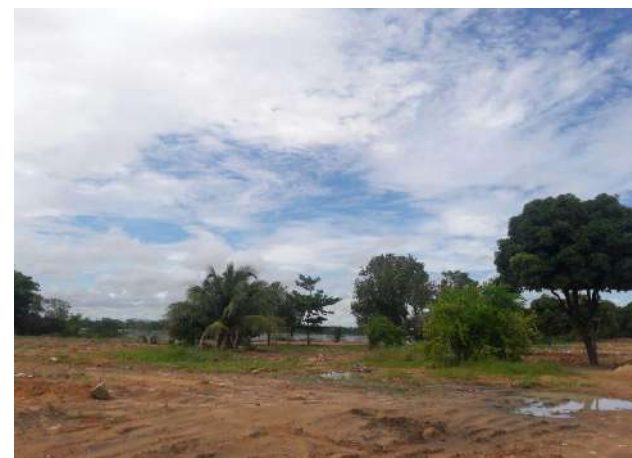
Figura 1 - Vista parcial do Beiral após a demolição das primeiras casas
